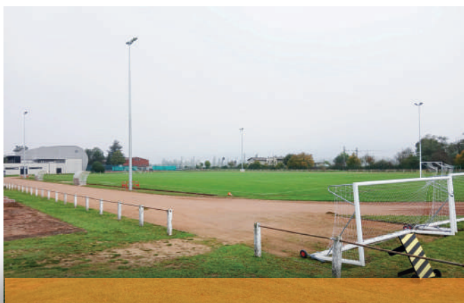
Le terrain de football avec quatre mâts d'éclairage à LED.
