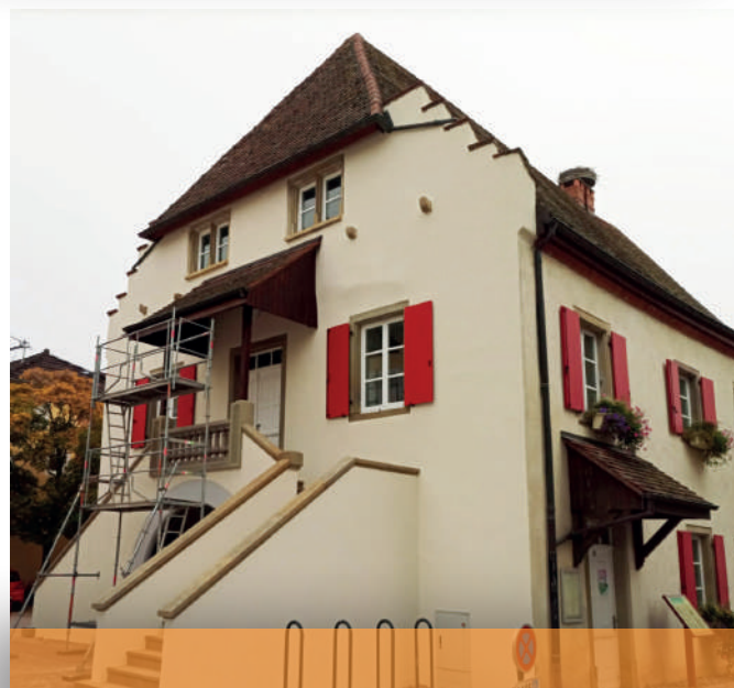
Réfection de la façade ouest du Rothüs.
